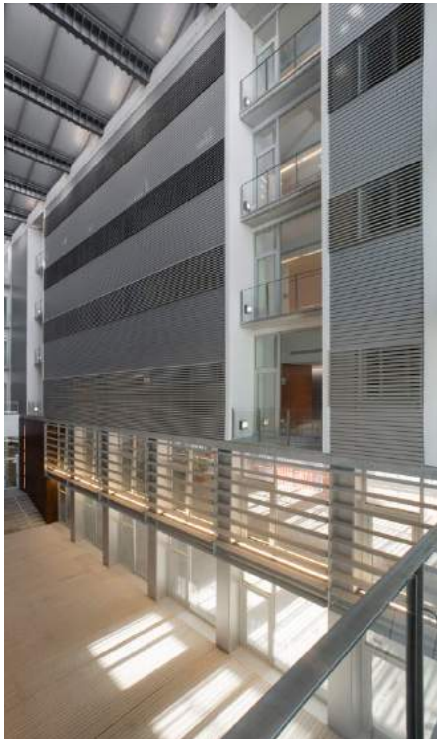
EDIFICIO SICIOSANITARIO BORBO
